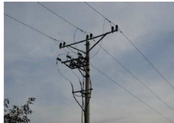
Linie 15 kV (napowietrzna i kablowa)
